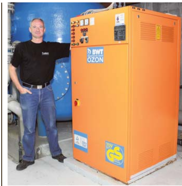
Die Ozonanlage desinfiziert das Wasser. Zuvor wird dem Wasser ein Flockungsmittel beigemischt (5), um Kleinstschmutzteilchen zu binden. Danach durchläuft das Badewasser zwei Sandfilter (6). Es fließt anschließend weiter in den Ozonreaktionsbehälter. Das Ozonzeugungselement (Bild) stellt unter Hochspannung Ozon (O 3 ) her, welches ebenfalls in den Reaktionsbehälter geleitet wird. Das Verfahren ist umweltschonend, da Ozon relativ schnell rückstandsfrei zerfällt und so keine Nebenprodukte entstehen. Stefan Widera von der Firma Best Water Technology aus Schriesheim bei Mannheim schaut bei der Ozonanlage des Hallenbades Waldshut nach dem Rechten, damit der Badebetrieb auch in der Saison 2011/2012 reibungslos funktionieren kann.
