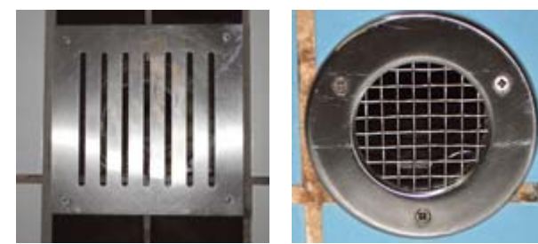
Durch die 22 Einlaufdüsen strömt sauberes Wasser ins Becken. Sie befinden sich am Boden (linkes Bild) oder am Rand (rechtes Bild). Das „abgebädete“, nicht mehr frische Wasser fließt über Ablaufrinnen in zwei Wasserspeicher, die sich im Keller befinden und in denen die Aufbereitung des Beckenwassers beginnt. Um „tote Punkte“, also Stellen im Becken, an denen keine Zirkulation mit frischem Wasser stattfindet, zu vermeiden, fließt im Hallenbad Waldshut das aufbereitete Wasser von unten nach oben.
